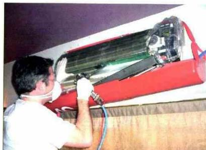
La dérive de la consommation électrique et la dégradation de l'état de l'air ou du niveau hygrométrique signalent un encrassement de l'échangeur de la climatisation. C'est le signal pour l'agent AC Cleaner de programmer une intervention.
